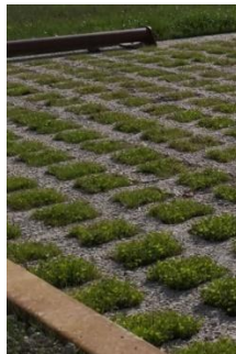
Béton alvéolaire avec un remplissage végétalisé
