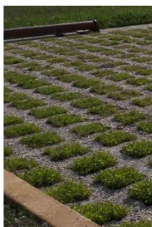
Béton alvéolaire avec un remplissage végétalisé
