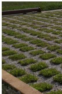
Béton alvéolaire avec un remplissage végétalisé
