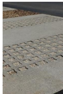
Béton alvéolaire avec un remplissage gravillonné
