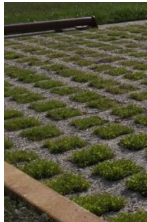
Béton alvéolaire avec un remplissage végétalisé
