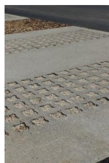
Béton alvéolaire avec un remplissage gravillonné
