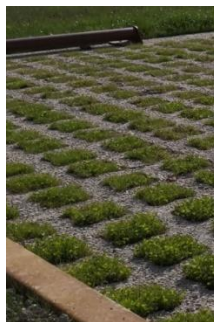
Béton alvéolaire avec un remplissage végétalisé
