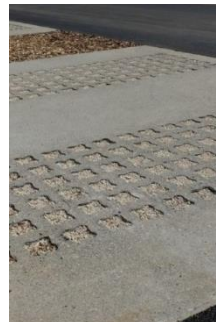
Béton alvéolaire avec un remplissage gravillonné
