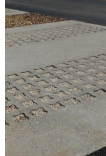
Béton alvéolaire avec un remplissage gravillonné
