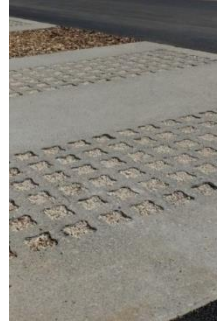
Béton alvéolaire avec un remplissage gravillonné
