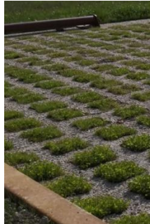
Béton alvéolaire avec un remplissage végétalisé
