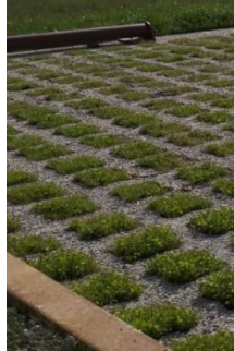
Béton alvéolaire avec un remplissage végétalisé
