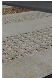
Béton alvéolaire avec un remplissage gravillonné
