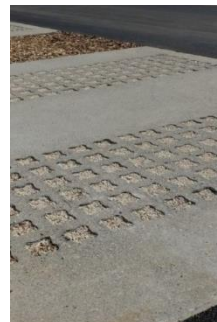
Béton alvéolaire avec un remplissage gravillonné
