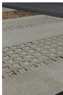
Béton alvéolaire avec un remplissage gravillonné
