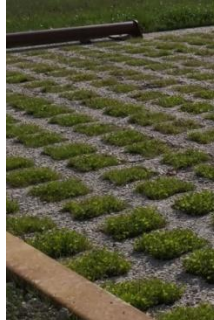
Béton alvéolaire avec un remplissage végétalisé
