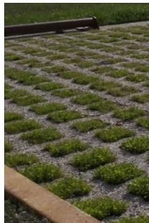
Béton alvéolaire avec un remplissage végétalisé
