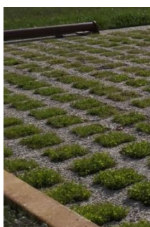
Béton alvéolaire avec un remplissage végétalisé
