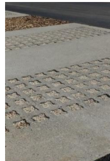
Béton alvéolaire avec un remplissage gravillonné
